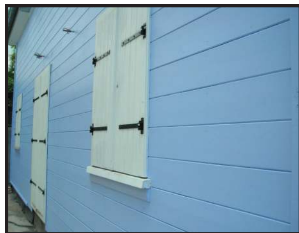
Appuis de fenêtre rallongé pour bardage et isolant. Menuiserie volet bois ou alu.
